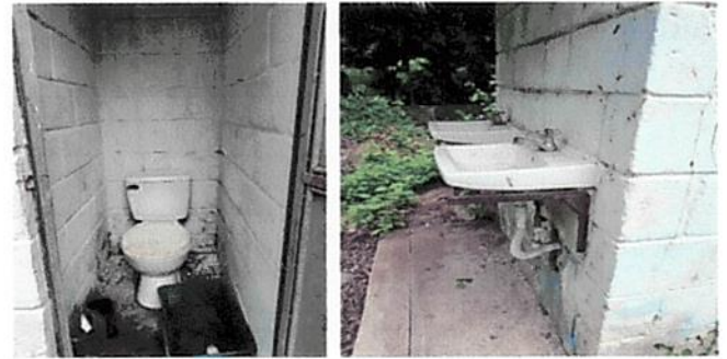
Foto 2: Mantenimiento de tres baños y dos lavamanos
