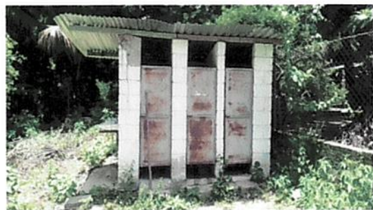
Foto 6: Reparación de banqueta de baños.
