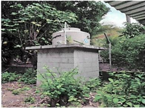
Foto 3: Cambio de tubería del tanque a baños .
